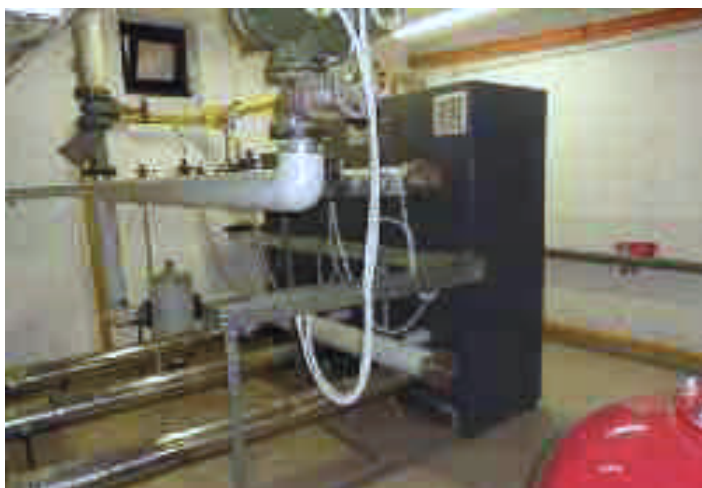
Riqualificazione centrale termica scuola elementare “San Filippo Neri” Birone.
