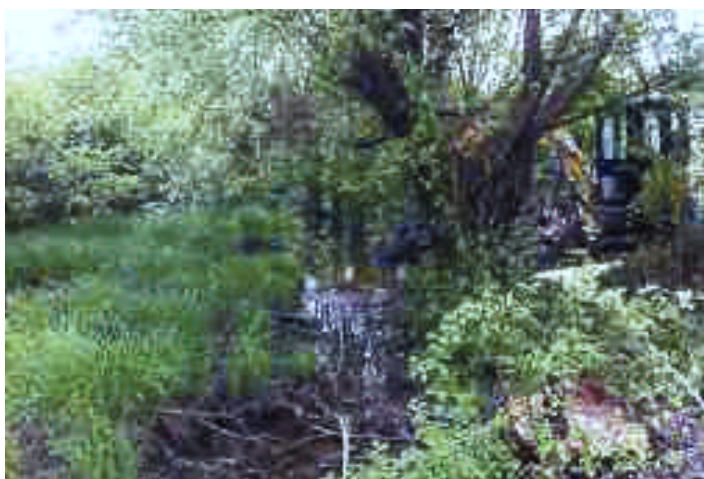
4) Ripristino della roggia della Foppa: ripulitura dalla vegetazione e dai materiali inerti, risagomatura dei fianchi e delle sponde e rimodellamento del fondo.
