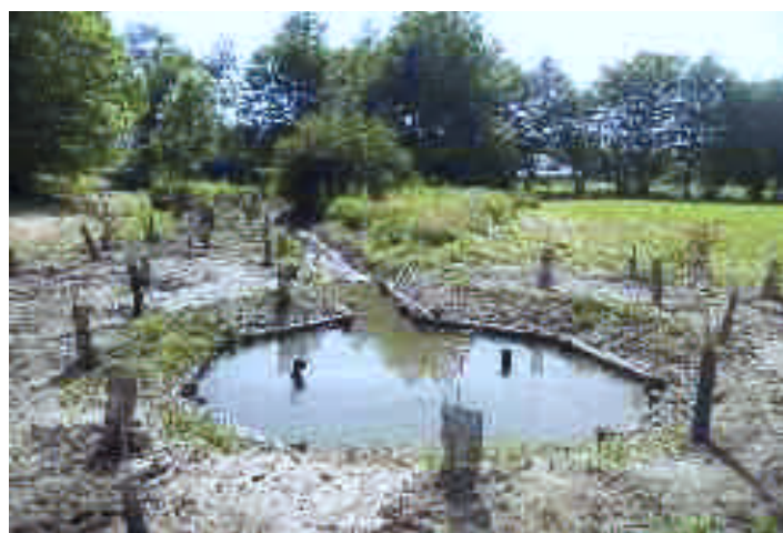
4) Ripristino della roggia della Foppa: ripulitura dalla vegetazione e dai materiali inerti, risagomatura dei fianchi e delle sponde e rimodellamento del fondo.
