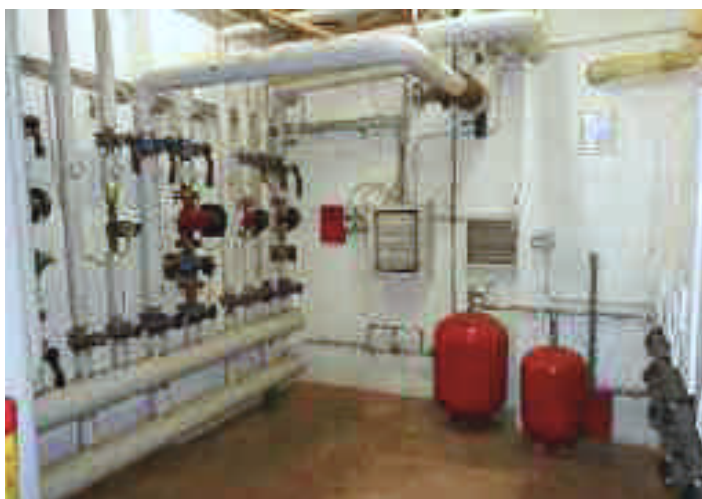
Riqualificazione centrale termica scuola elementare “Ada Negri” Paina.
