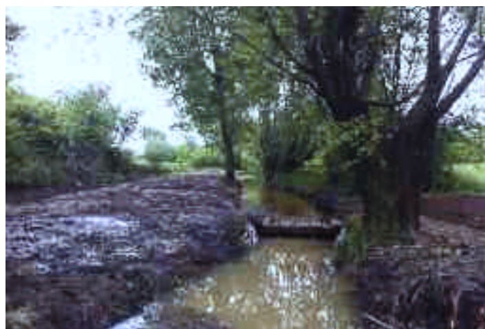
4) Ripristino della roggia della Foppa: ripulitura dalla vegetazione e dai materiali inerti, risagomatura dei fianchi e delle sponde e rimodellamento del fondo.
