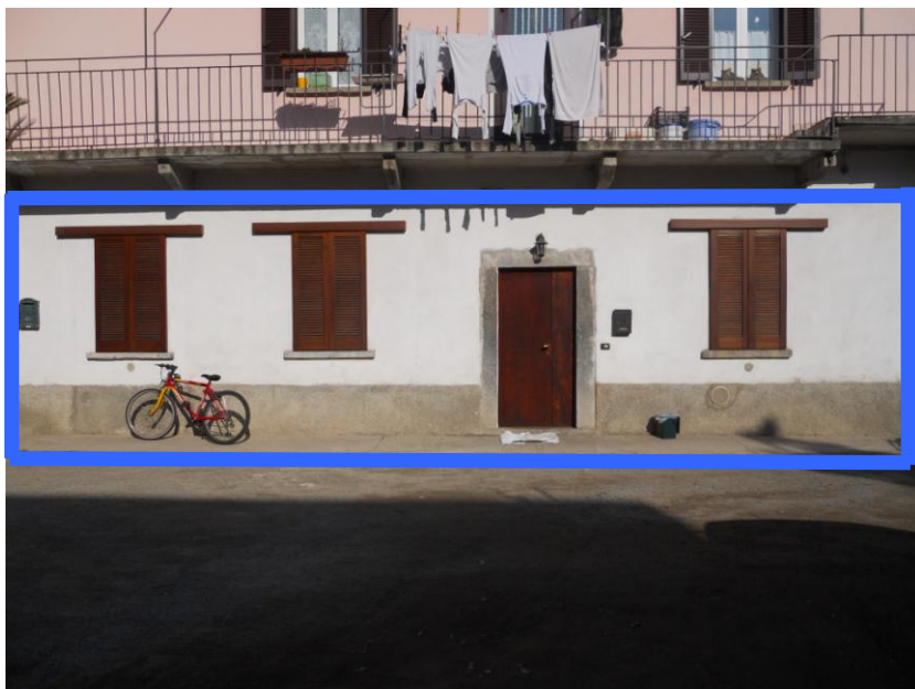
Ingresso alloggio interno alla corte comune
