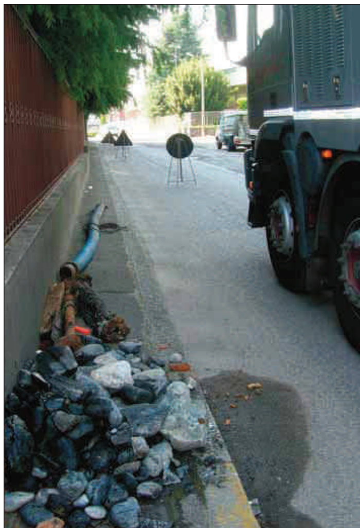
In questa foto, l'autocisterna degli spurghi in azione e, a lato, un significativo esempio di raccolta del materiale che ostruiva le condotte
