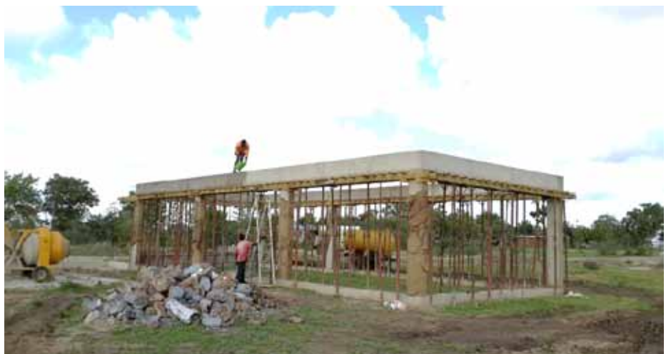
Trave aerea completata dalle maestranze locali
