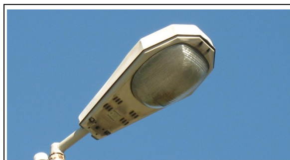
FIG. 5 - Esempio di armatura stradale chiusa con coppa a vetro curvo
