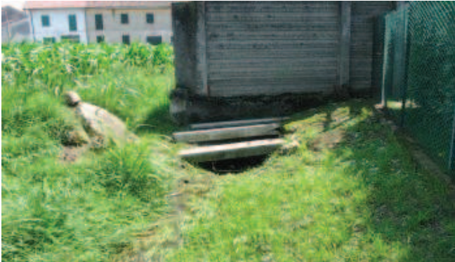
Fig. 6.37 Il tombino di ingresso del tratto T4
