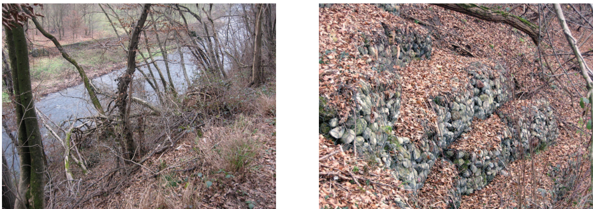
Figg. 6.8 - 6.9 Sponda ripida e gabbioni nel tratto 1 a valle della ex Cartiera
