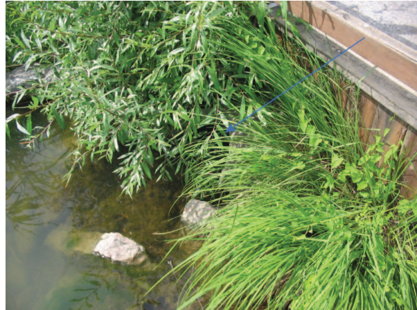
Fig. 6.38 L'ingresso della tubazione nel Laghetto
