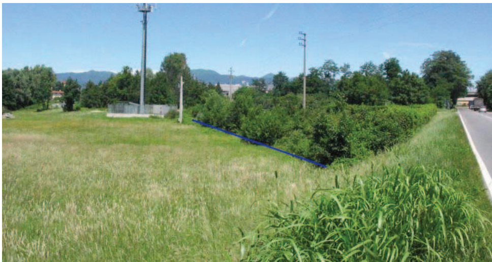
Fig. 6.35 Il tratto della fascia agricola
