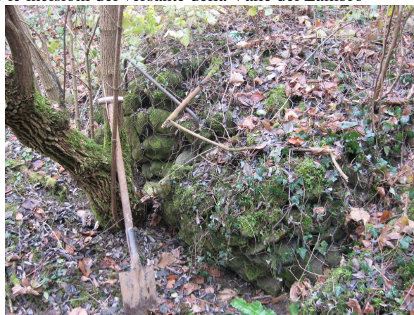
Fig. 3.60 Gabbioni per il contenimento di portate solide a monte della "Lamplast"
