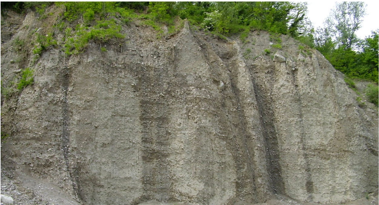
Fig. 3.30 Il fronte inutilizzato, ma in erosione, della vecchia cava alle cartiere Villa, ora Casiraghi
