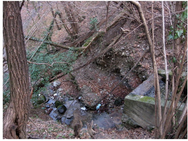
Figg. 3.23, 3.24 Le incisioni lungo il versante destro e le opere di convogliamento idrico, con banchi di Ceppo
