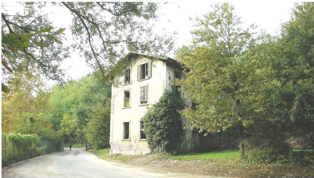
L'EDIFICIO ALL'INGRESSO CIRCONDATO DAL "VERDE"
