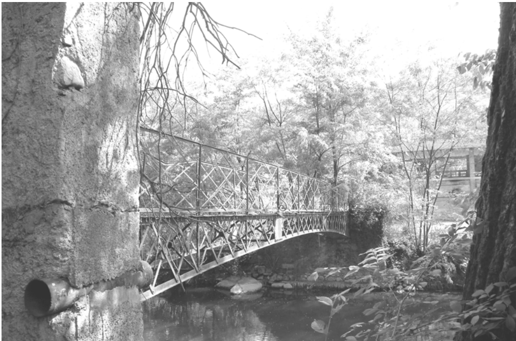
Ponte pedonale sul fiume Lambro
