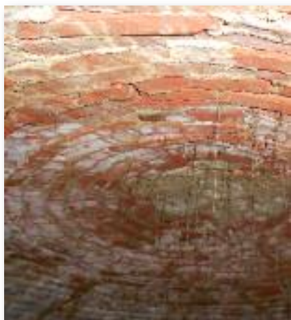
Nel corso dei lavori è stata rinvenuta una camera a cupola che risale alle opere di bonifica effettuate dai Padri Certosini di Paina nell'area del laghetto. A pag. 24.
