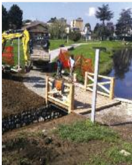
Lavori in corso per il recupero idrico delle risorgive e degli affluenti del Laghetto di Giussano. In copertina, il salto d'acqua realizzato per ossigenare le acque; sopra il ponticello in corso di realizzazione.
