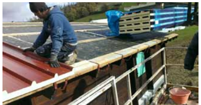
I primi lavori di rifacimento dei tetti delle stalle terremotate
