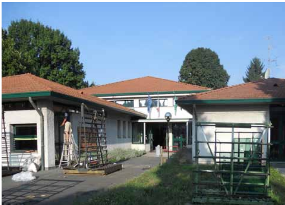
Interventi di messa in sicurezza della scuola dell'Infanzia "Piccole Tracce"
