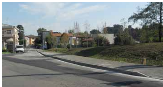
La Via Viganò oggetto di un intervento di rifacimento e riqualificazione del tratto di rete fognaria
