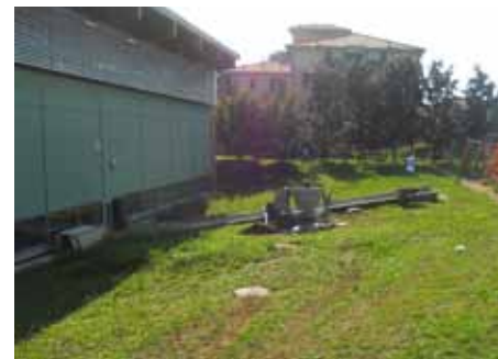
Lavori in corso presso la palestra di Robbiano
