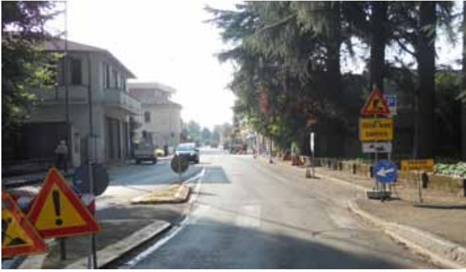
Intervento di riqualificazione dei marciapiedi di Via Piola
