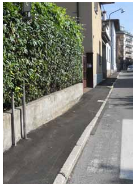
Intervento di riqualificazione dei marciapiedi di Via Pellico
