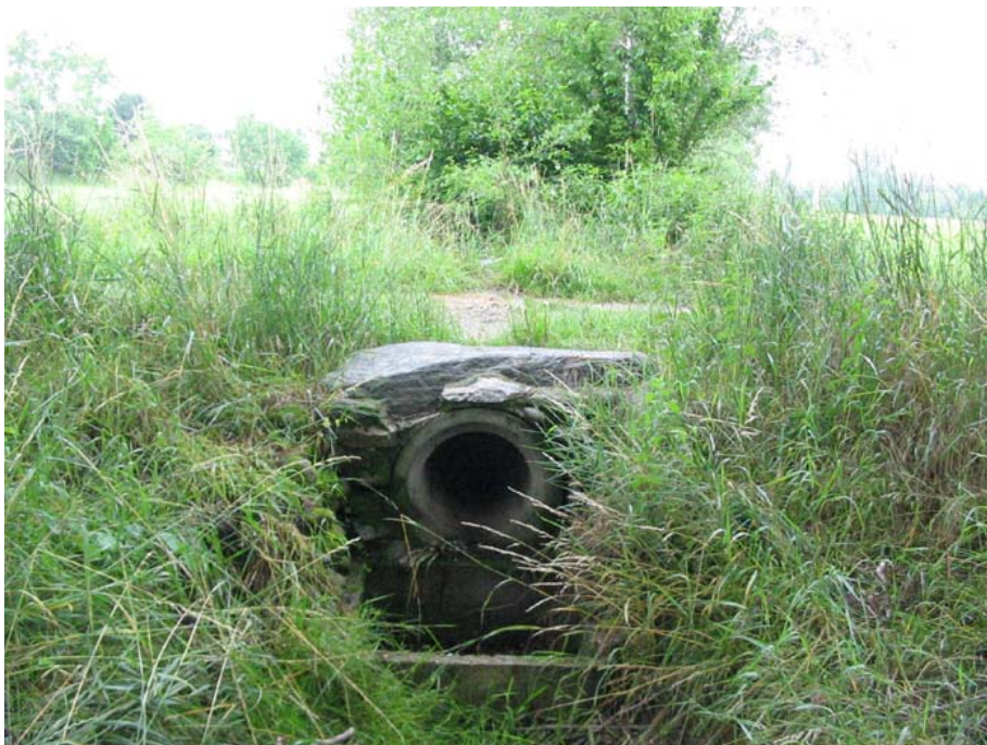
Fig. 6.25 Tubazione di collegamento sotto la strada poderale
