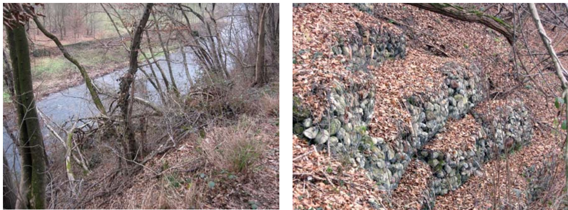
Figg. 6.8 - 6.9 Sponda ripida e gabbioni nel tratto 1 a valle della ex Cartiera
