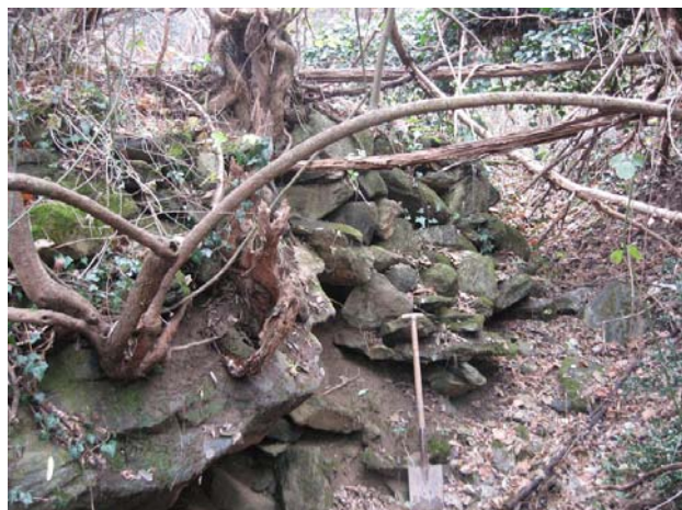
Fig. 6.73 Muro di contenimento in blocchi in alveo
