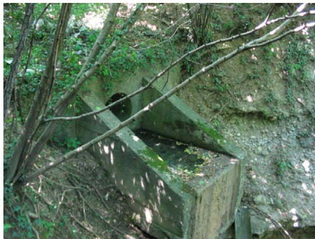
Fig. 6.54 L'opera di scarico delle acque stradali
