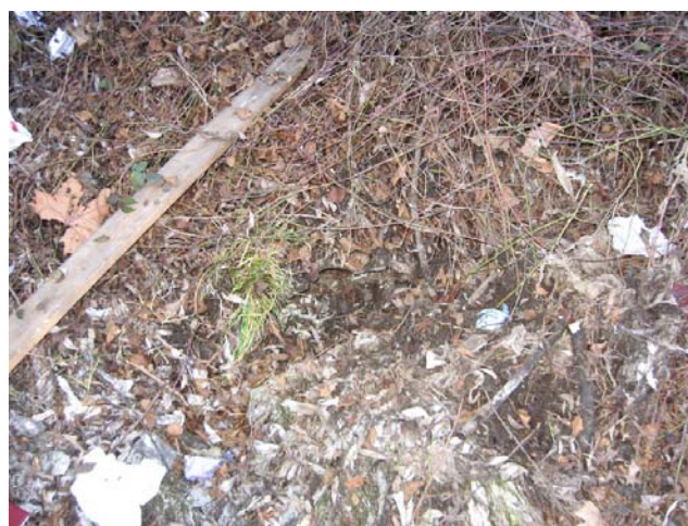
Fig. 6.70 È appena visibile il bordo superiore della tubazione di scarico a Lambro, intasata da terra e rifiuti
