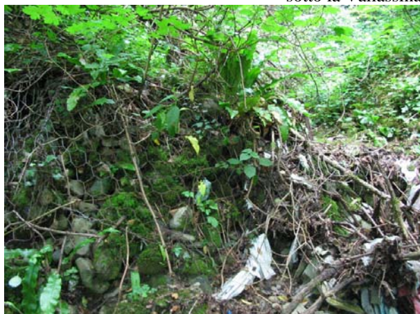
Fig. 6.65 Gabbioni parzialmente disestati
