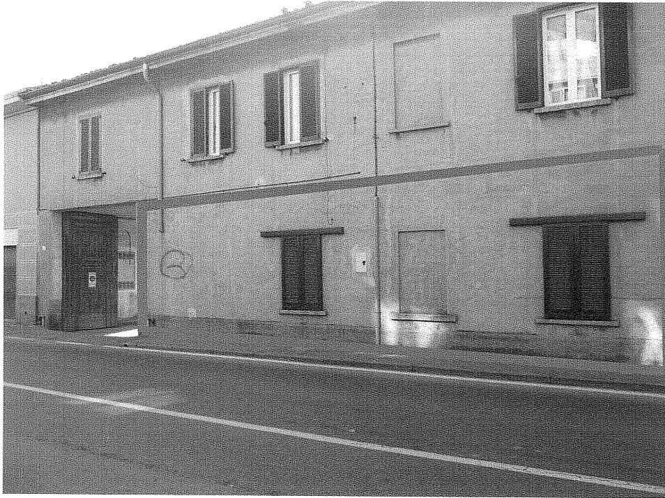
Ingresso carraio e pedonale alloggio da via Cavour
