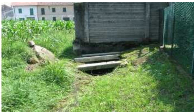
Fig. 6.37 Il tombino di ingresso del tratto T4
