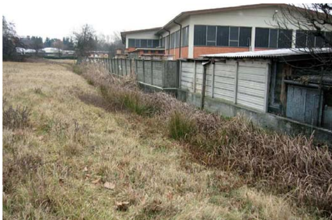
Fig. 6.42 La roggia nel tratto 1
