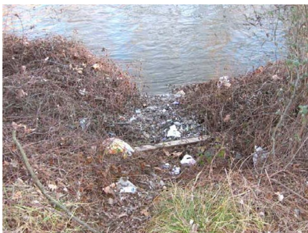
Fig. 6.69 Zona dello sbocco della tubazione sull'argine
