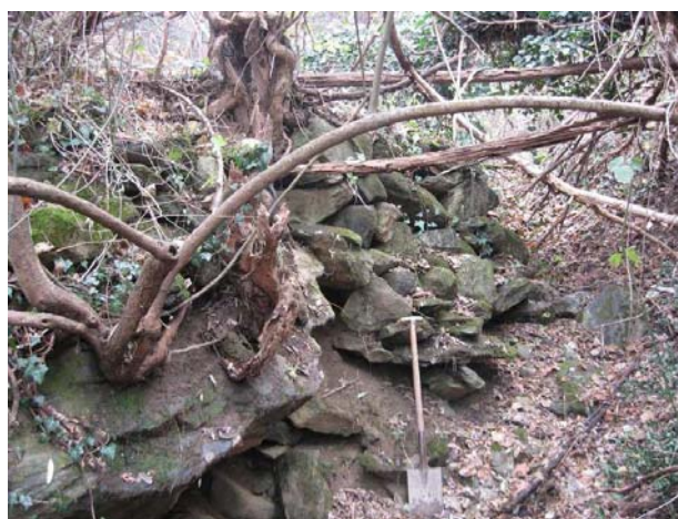
Fig. 6.73 Muro di contenimento in blocchi in alveo
