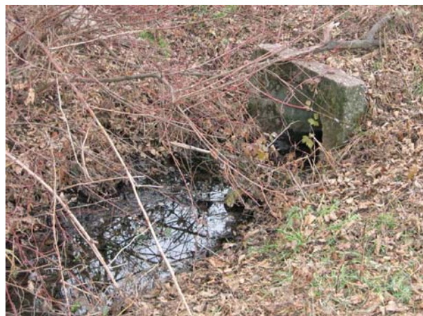
Fig. 6.43 La tubazione al termine del tratto 2
