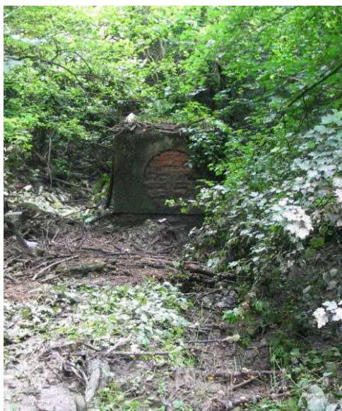
Fig. 6.50 L'opera di presa del Riale
