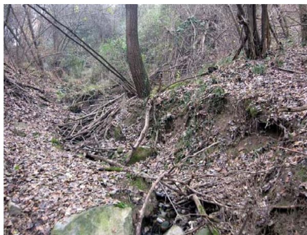
Fig. 6.81 Erosioni spondali e generale dissesto presso la testata della valle
