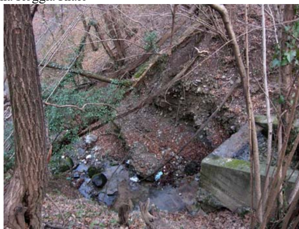
Figg. 3.23, 3.24 Le incisioni lungo il versante destro e le opere di convogliamento idrico, con banchi di Ceppo
