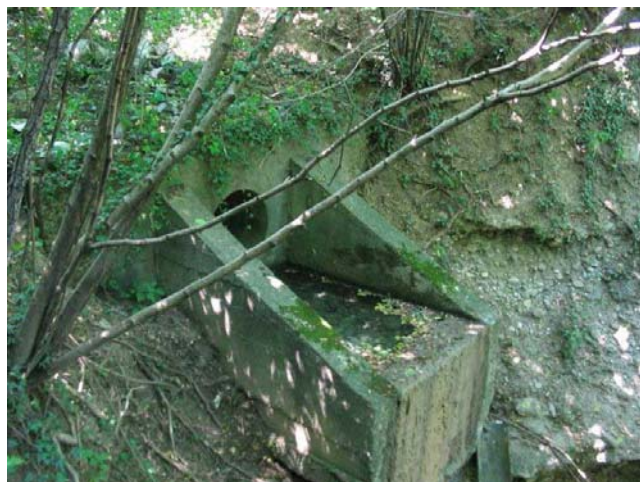
Fig. 6.54 L'opera di scarico delle acque stradali
