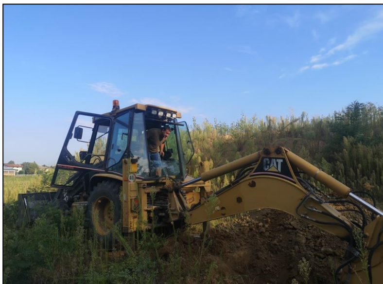
Fotografia 6: Operazioni di scavo.
