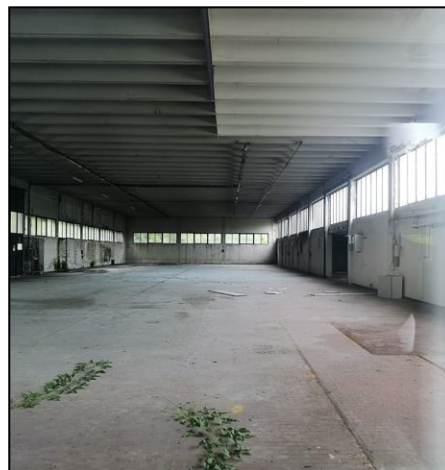
Fotografia 3: Interno del capannone.
