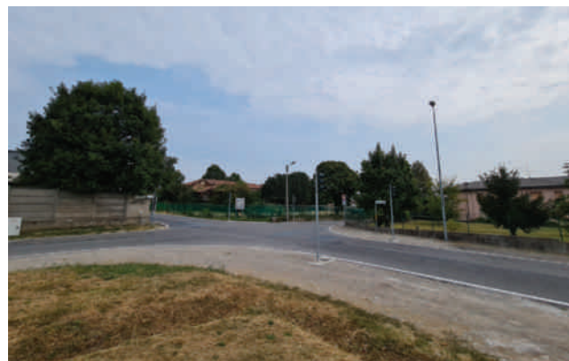
Nuovo impianto semaforico tra Via della Tecnica, Via Ugo Foscolo, Via dell'Artigianato
