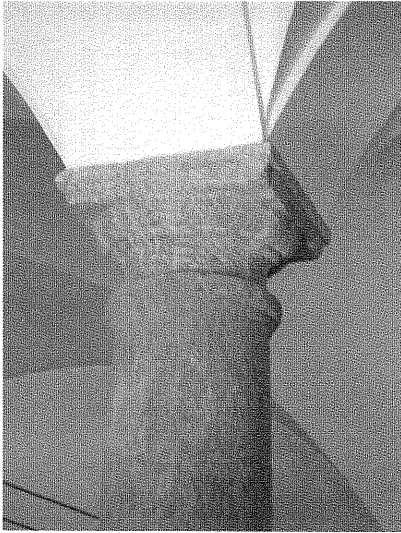
Particolari delle colonne in ghiandone
