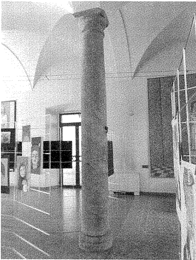
Particolari delle colonne in ghiandone
