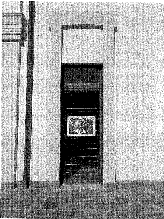
Particolare della cornice esterna dei serramenti
