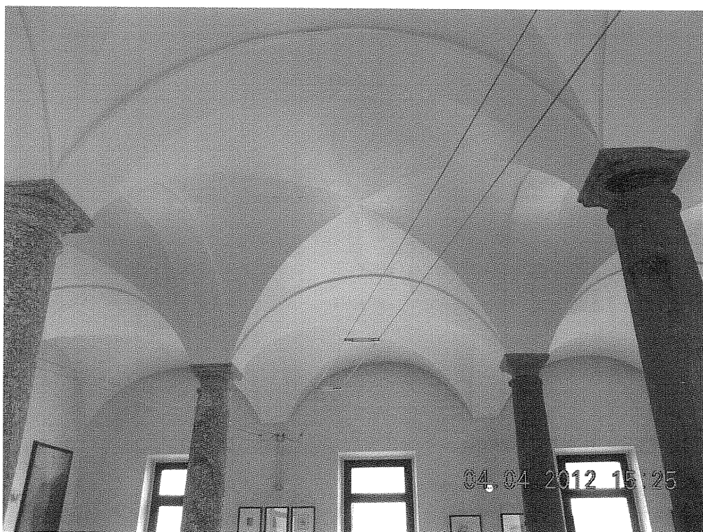
Volte a crociera intonacate
