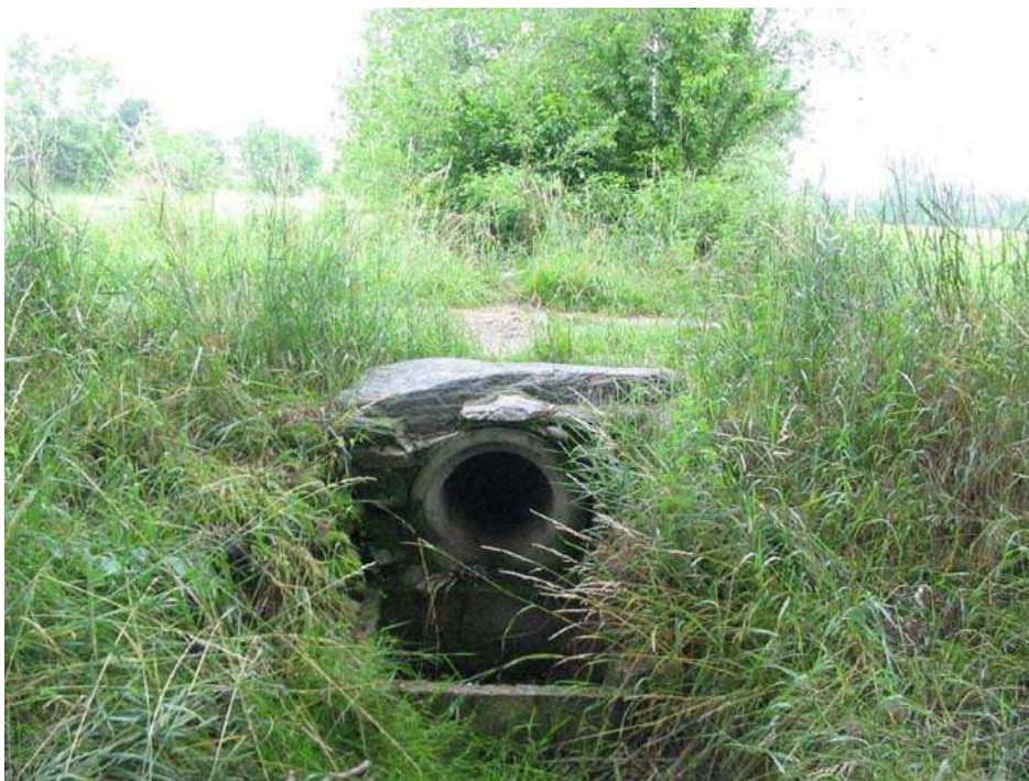
ig. 6.25 Tubazione di collegamento sotto la strada poderale
