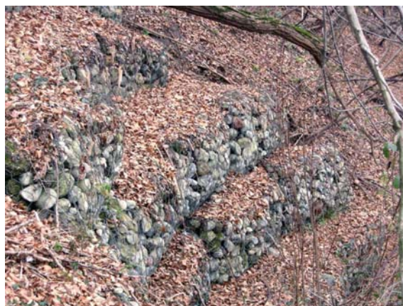
Figg. 6.8 - 6.9 Sponda ripida e gabbioni nel tratto 1 a valle della ex Cartiera
