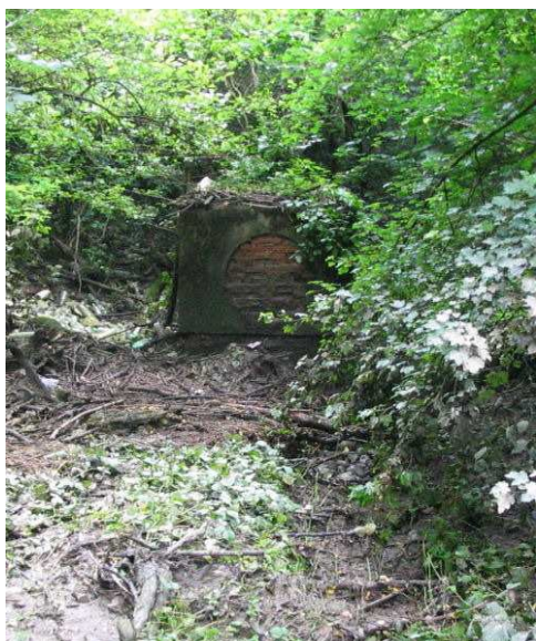
Fig. 6.50 L'opera di presa del Riale
