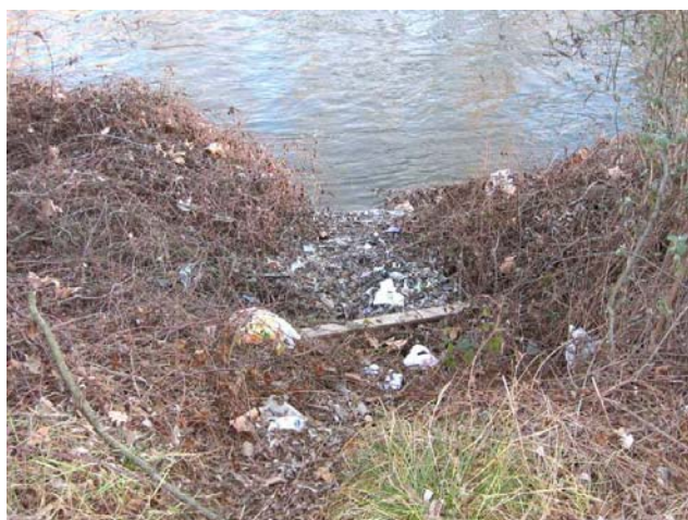
Fig. 6.69 Zona dello sbocco della tubazione sull'argine
