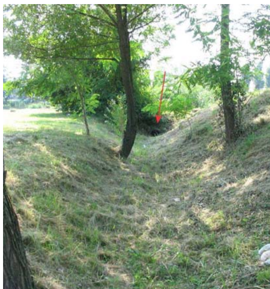
Fig. 6.29 Parte finale del tratto 4 e imbocca tubazione di scarico nel Laghetto
