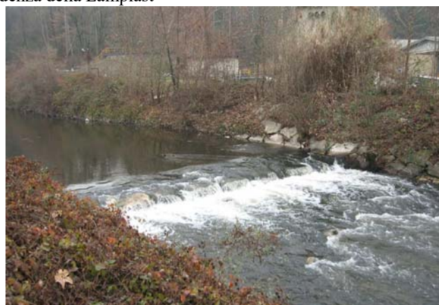
Fig. 6.17 Argine in grossi blocchi di rocce varie in corrispondenza della Lamplast
