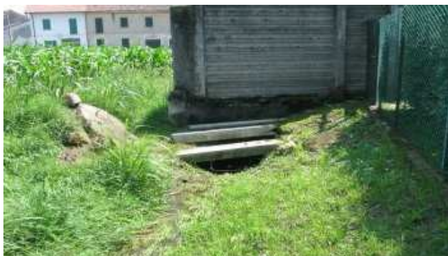
Fig. 6.37 Il tombino di ingresso del tratto T4
