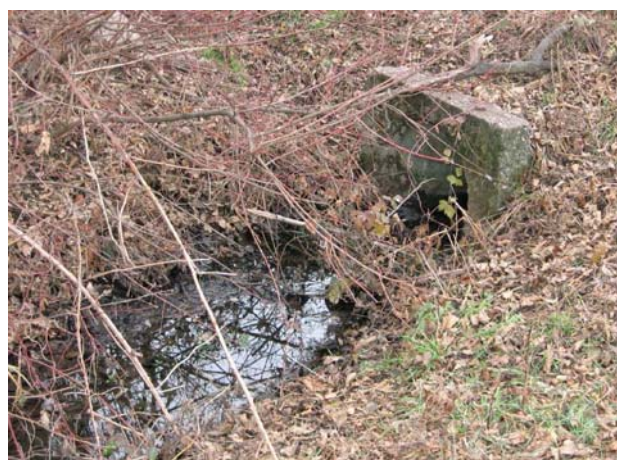
Fig. 6.43 La tubazione al termine del
