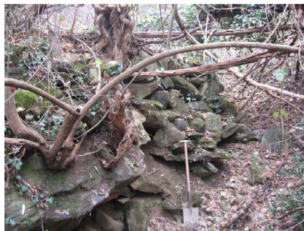
Fig. 6.73 Muro di contenimento in blocchi in alveo
