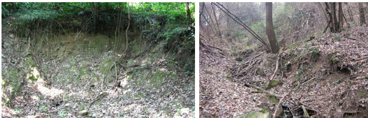
Figg. 3.57- 3.58 Frane di sponda e scoscendimenti lungo le incisioni del versante della Valle del Lambro
