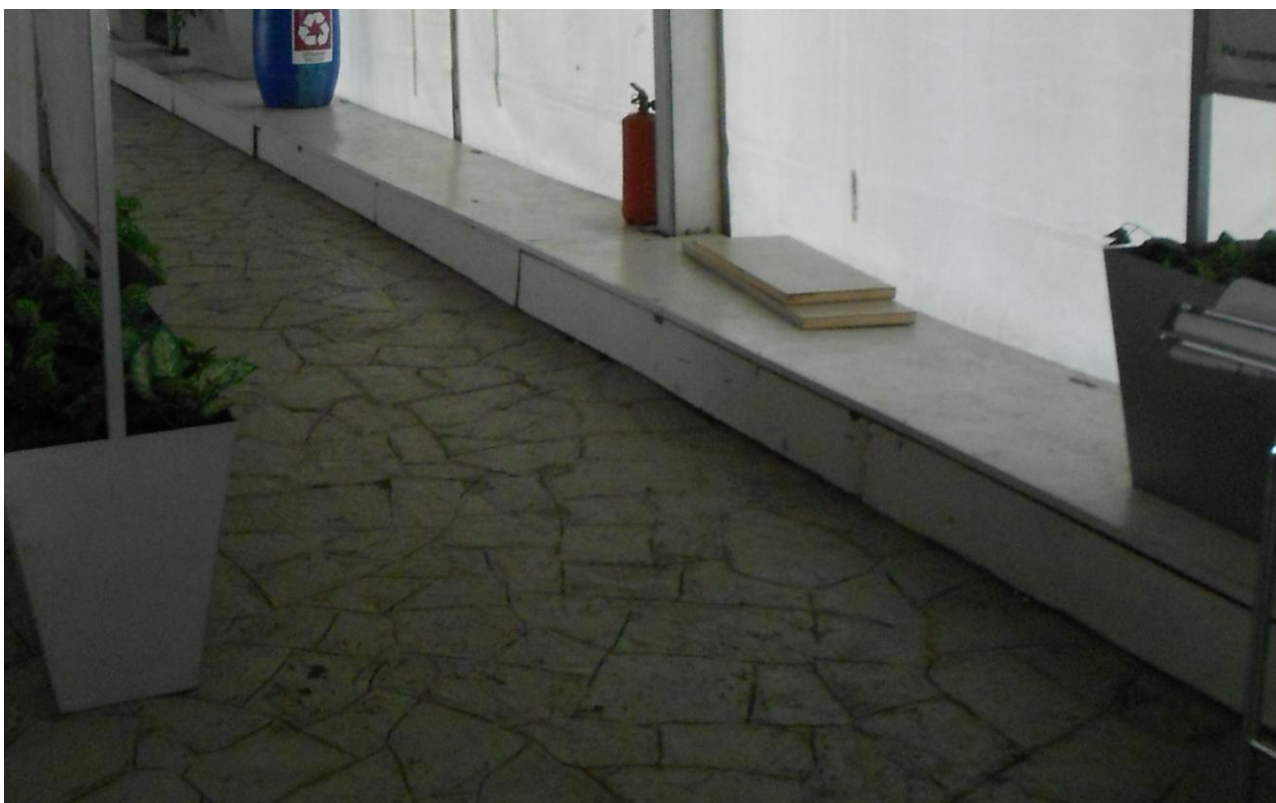
Cassonetto in legno a rivestimento del muretto laterale da smontare e smaltire.
